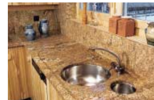
Küche erstellt Mitte der 80er-Jahre. Becken von unten montiert, Tropfteil eingeschliffen. Beige-goldfarbene Farbtöne dominieren.
