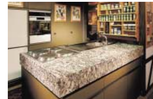
Küche erstellt anfangs der 70er-Jahre. Einlegeeile von oben eingebaut.
