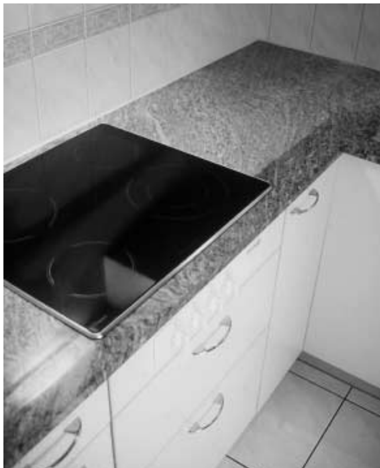
Foto 4 Küchenabdeckung mit fehlerhafter Imprägnierung: Das Gestein hat entlang der Vorderkante stark abgedunkelt – in dieser Zone ist die Imprägnierung nicht wirksam. Im hinteren Teil zeigt das Gestein durch Erhaltung seiner ursprünglichen Farbe, dass die Imprägnierung wirksam ist.
